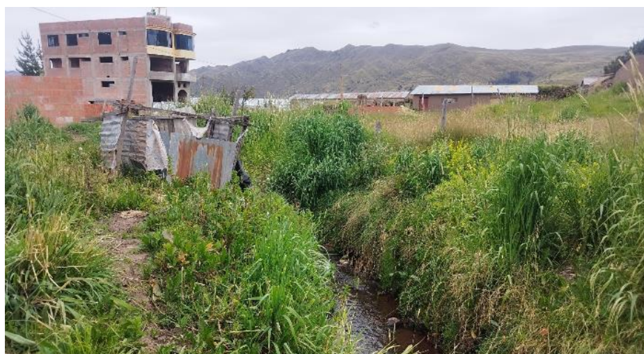
FIGURA N° 02: SE APRECIA EL CAUCE ESTRANGULADA, EL CUAL INTERRUMPE EL NORMAL FLUJO DEL AGUA, REQUERIENDO LA LIMPIEZA Y DESCOLMATACIÓN DEL CAUCE DE LA QUEBRADA TUCSAQUIRE.
